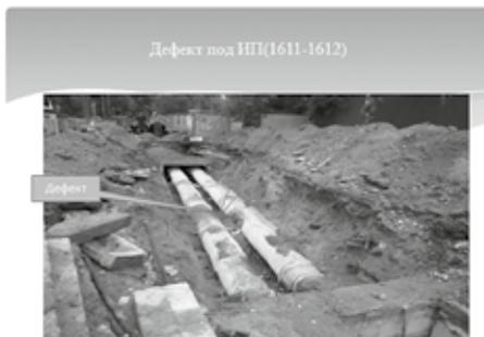
Рис. 4. Дефект в стенке трубы (несквозной)
