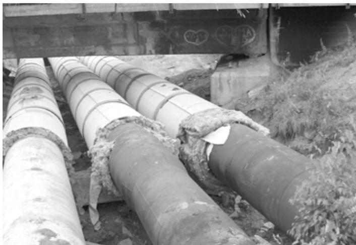
Рис. 2. Пример диагностируемого участка теплотрассы наружной прокладки в условиях города
