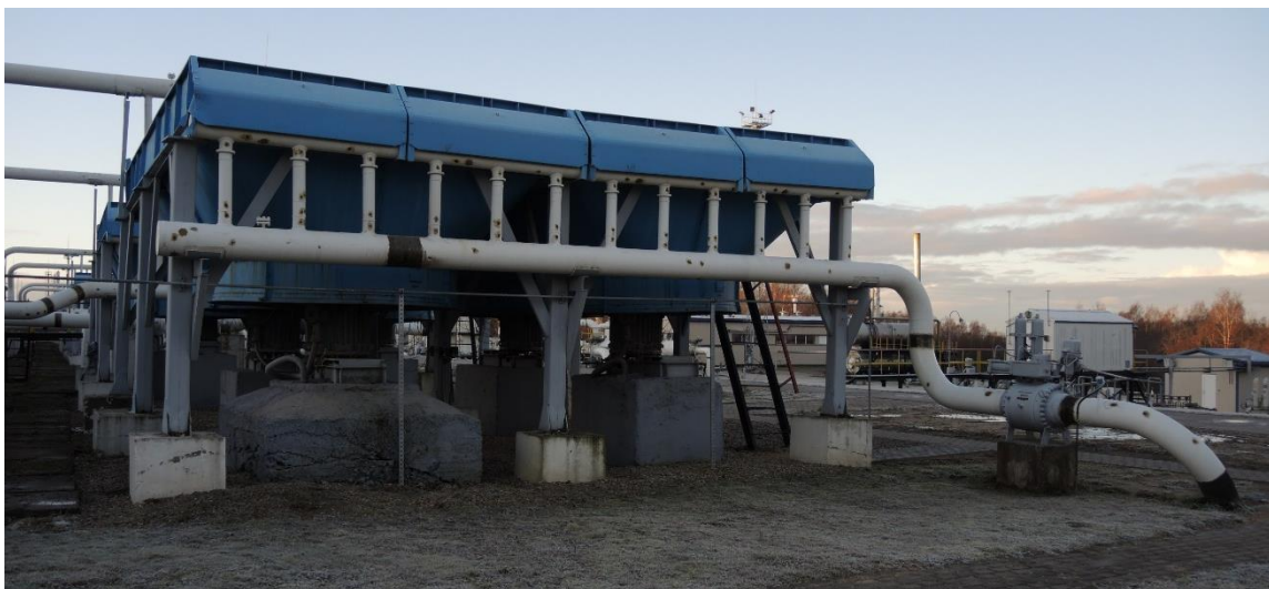
Рис. 10.4. Испытываемый аппарат воздушного охлаждения
